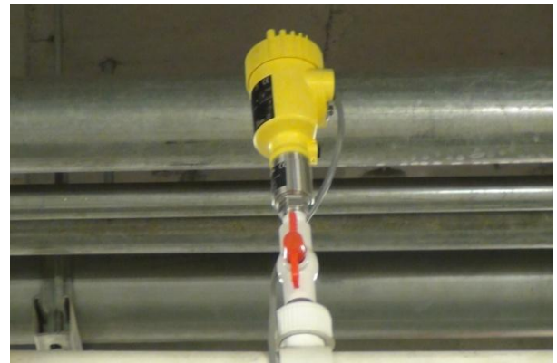
Figura 7 Sensor de presión de la Red Elevada.
