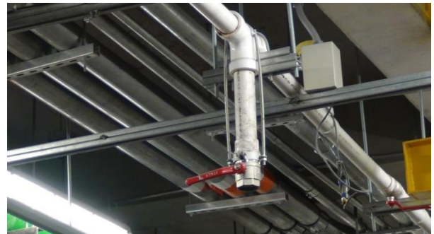
Figura 4 Válvula de bola de la red elevada.
